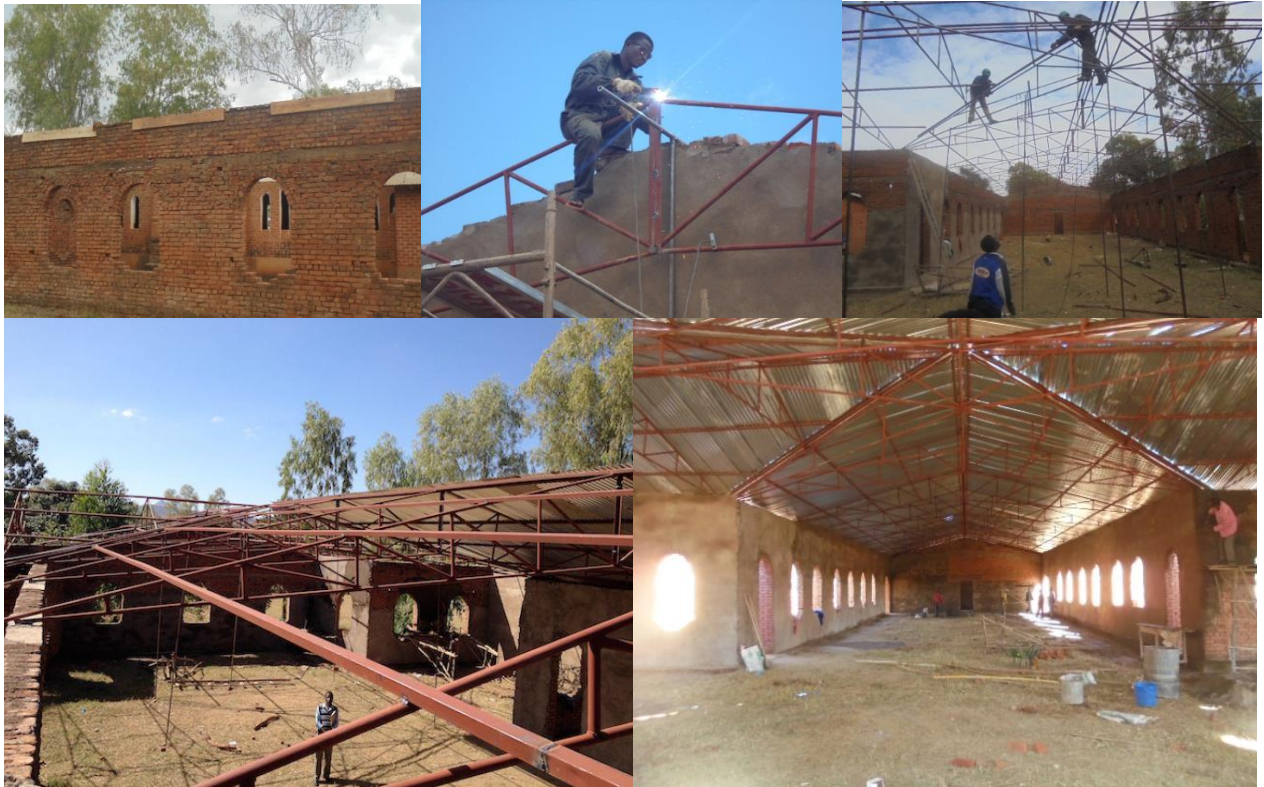
Zomaar wat momenten van het church roofing project
